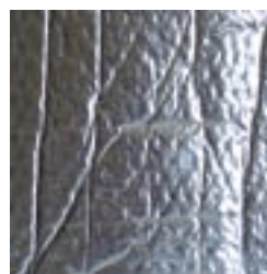
Detail exterieur couverture
