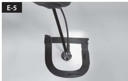
Infoga mottagare kabel och 5c strömkabel genom hålet
