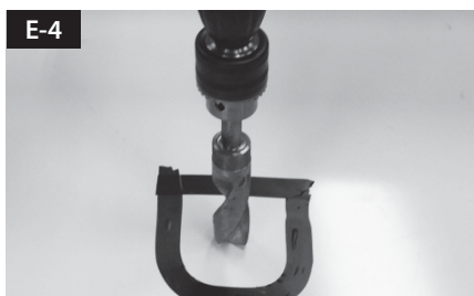
Haga un agujero de taladro de 15mm, en el centro de la marca de cinta
