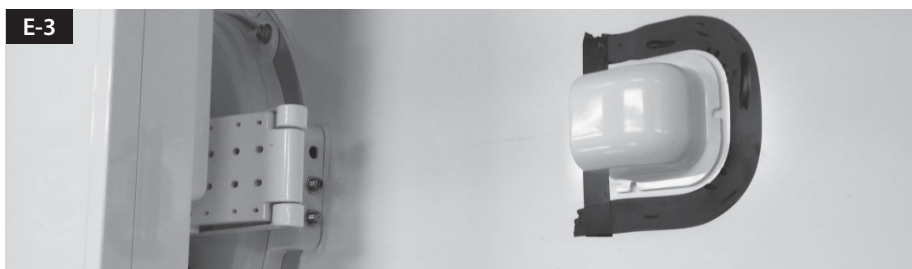
Placera kabelhuset framför (30cm från) antenn centrum med öppna sidan av kabelhuset vänd mot anslutningarna på antennen. Fäst sedan skyddstejp runt kabelhuset.
