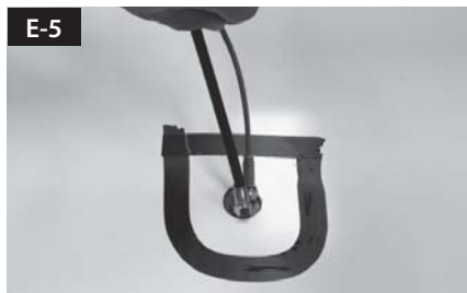
Ziehen Sie das Empfängerkabel und das 5C Stromkabel durch das Loch.
