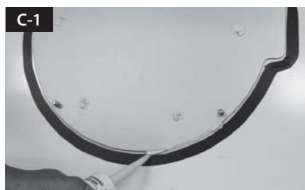
Appliquez de la silicone autour de la plaque de montage
