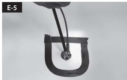
Inserte a través del agujero el receptor y el cable de energía 5c
