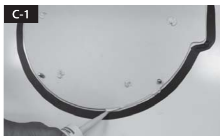
Breng siliconenkit aan rondom de bevestigingsplaat
