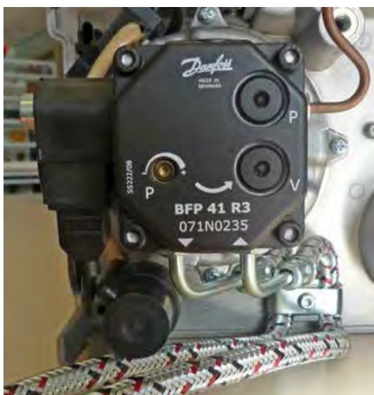
Aansluiting drukmeter en vacuümmeter
