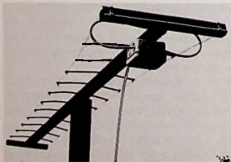
Afb. 43 14-Elements-UHF-antenne, op het balkon gemonteerd (de spandraden wijzen in de richting van de zender en hebben dus geen nadelige invloed).
