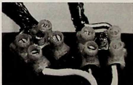
Afb. 20 De kroonsteentjes die onder het dragende afdekplaatje zijn gemonteerd en die zowel het raamwerk vasthouden als voor de elektrische aansluiting zorgen.
